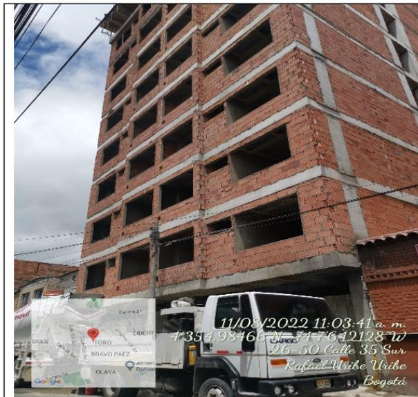
**Fotografía 11.** Estructura sin presentar instalación de malla.
