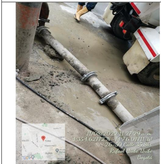
**Fotografía 15.** Alcantarilla afectada por vertimiento directo. ubicado en las coordenadas 4°35'5,865 N – 74°7'5,75" W
