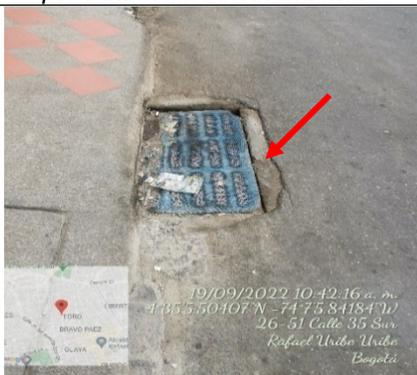
**Fotografía 6.** Sumidero sin afectación y sin el respectivo cubrimiento sobre la carrera 26Bis A
