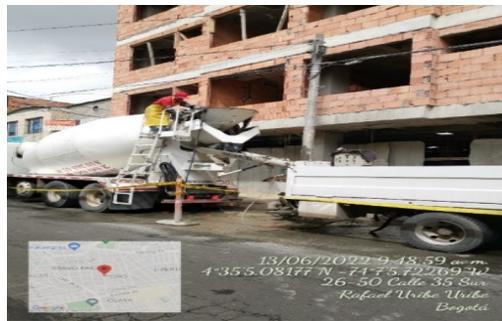
**Fotografías 3 y 4.** Agua contaminada producto del lavado del mixer, vertida en la red de drenaje urbano.
